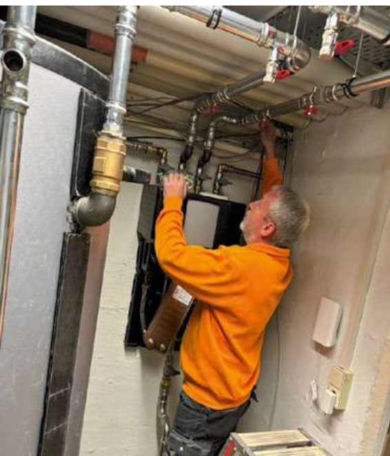
Leopoldplatz in Rastatt - Anbindung an die Nahwärme der Stadtwerke Rastatt
