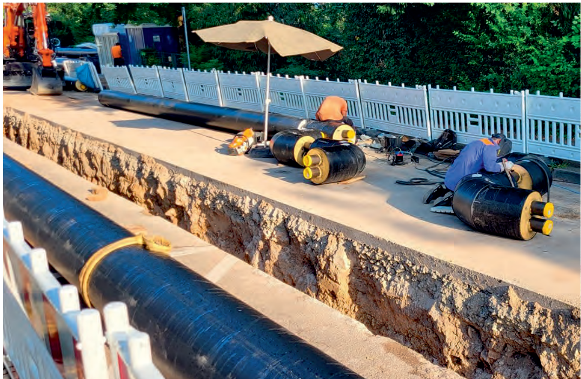
Nahwärmearbeiten mit neuer Wärmeübergabestation am Leopoldplatz in Rastatt
