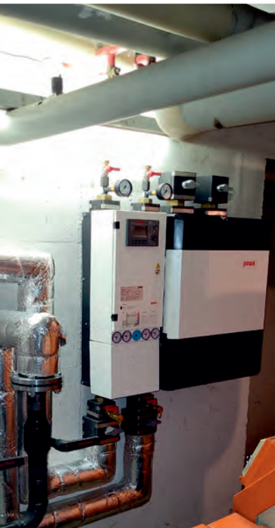
Nahwärmearbeiten mit neuer Wärmeübergabestation am Leopoldplatz in Rastatt
