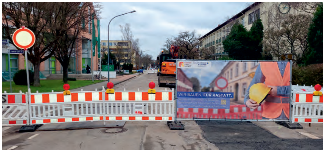
Leopoldplatz in Rastatt - Anbindung an die Nahwärme der Stadtwerke Rastatt
