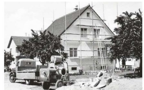
Nach dem Zweiten Weltkrieg entstehen viele Häuser in serieller Bauweise, um so schnell neuen Wohnraum zu schaffen, der dringend benötigt wurde. Foto: BG Familienheim
