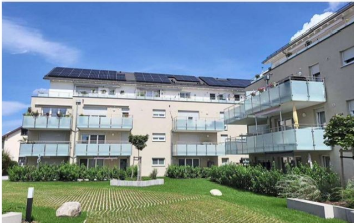
Energieeffizientes Bauen hat sich die BG auf die Fahnen geschrieben: In der Franz-Abt-Straße wurde Photovoltaik verbaut. Foto: BG Familienheim
