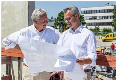
Der nebenamtliche Vorstand Rupert Felder (links) und der geschäftsführende Vorstand Marco Haugs auf der Baustelle in der Platanenstraße in Rastatt. Foto: BG Familienheim
