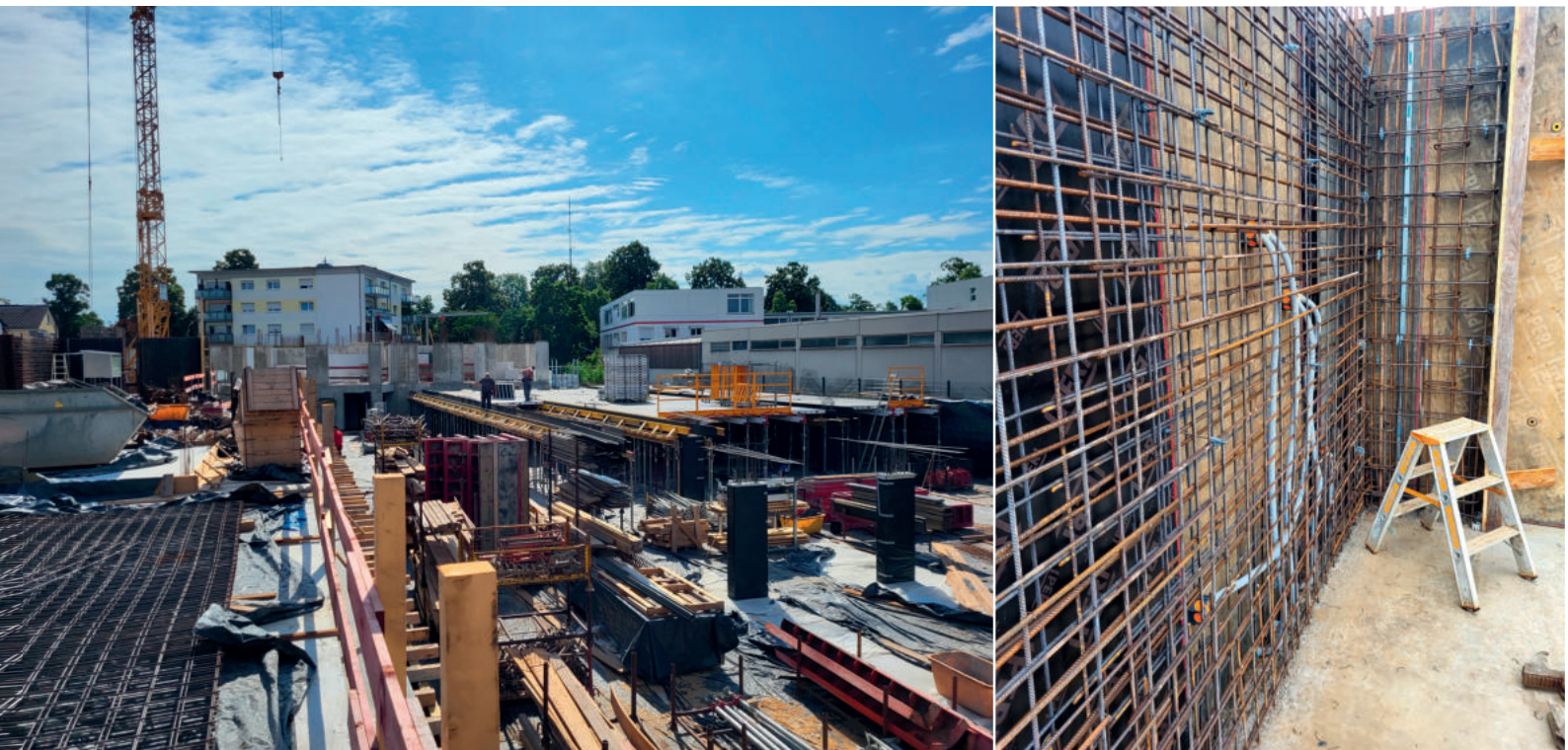
Baustellenbilder Neubau von 60 genossenschaftlichen Mietwohnungen in der Platanenstraße in Rastatt
