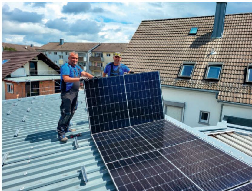
Installation der Photovoltaikanlage am Geschäftshaus Familienheim Rastatt eG
